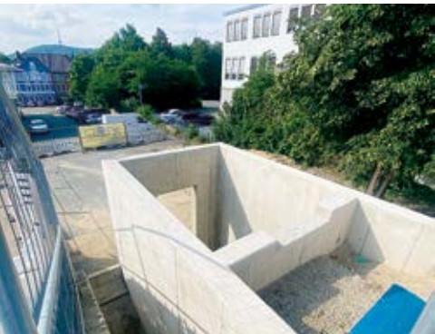
Derzeit noch im Bau: Der Fahrstuhl an der Hüttenstraße soll bis Ende des Jahres fertig sein.
